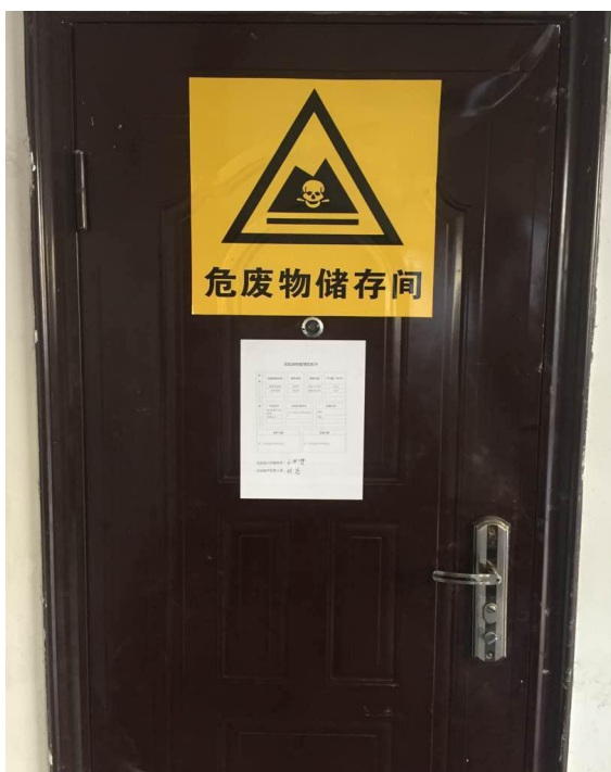
危废堆场外景
