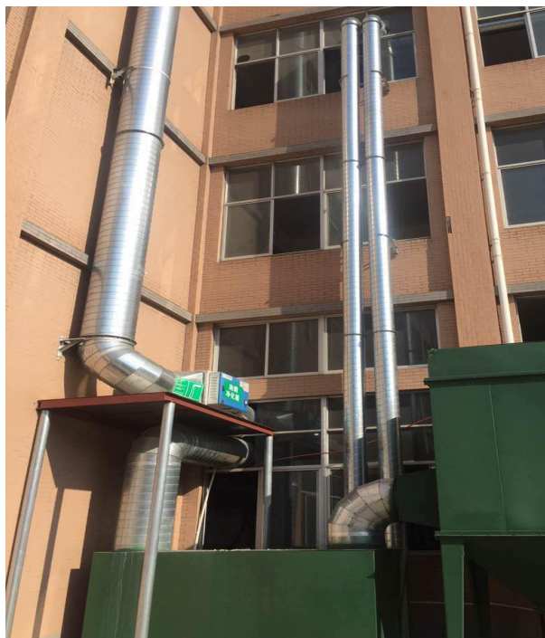
油烟净化器及废气管路整改接布袋除尘设施
