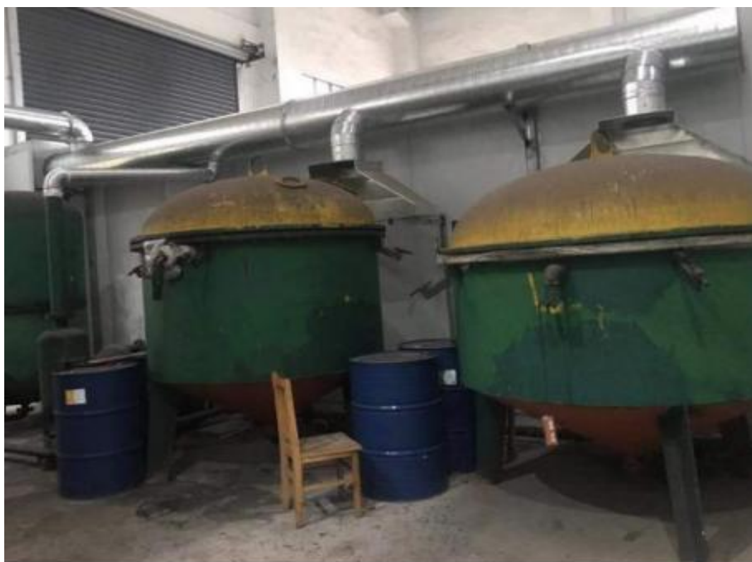
浸漆废气收集 2
