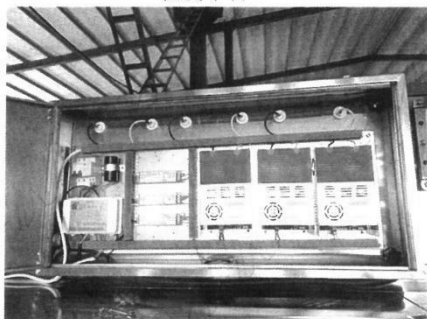
高压电源 镇流器
